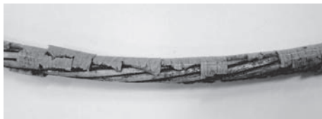
图 2 架空电缆绝缘材料老化开裂局部图
