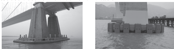
(a) 自浮式防撞装置; (b) 固定式防撞装置
