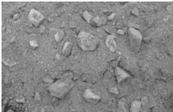
图1 压实前的粗级级配填料
