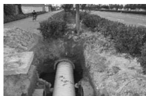
图5 部分开挖修复损毁管道
