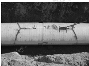
图4 双层缠绕管材的承插连接
