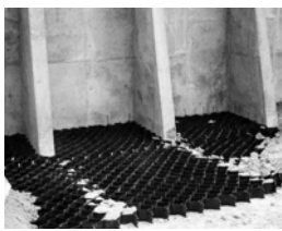
图4 台背填筑现场实景
