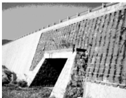
图6 某土工格室挡土墙实景
