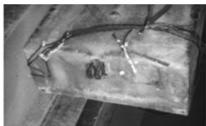
图 3 主龙骨因拉脱而破坏
