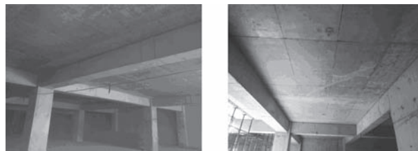
图 5 中国新兴建筑京粮项目部拆模效果图
