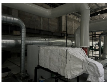
图10 天然气直燃系统生产试验图
